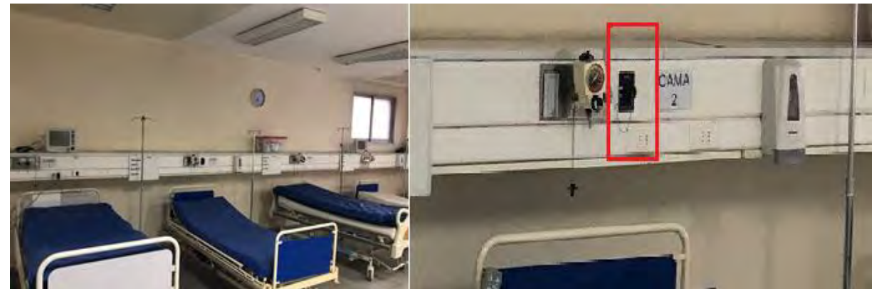
Integración Red de Aire Medicinal en Recuperación Pabellón Central
